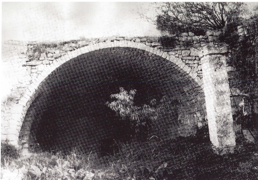
Grange voûtée en pierre sèche, typique des massarie du XIII e siècle dans les Pouilles.
